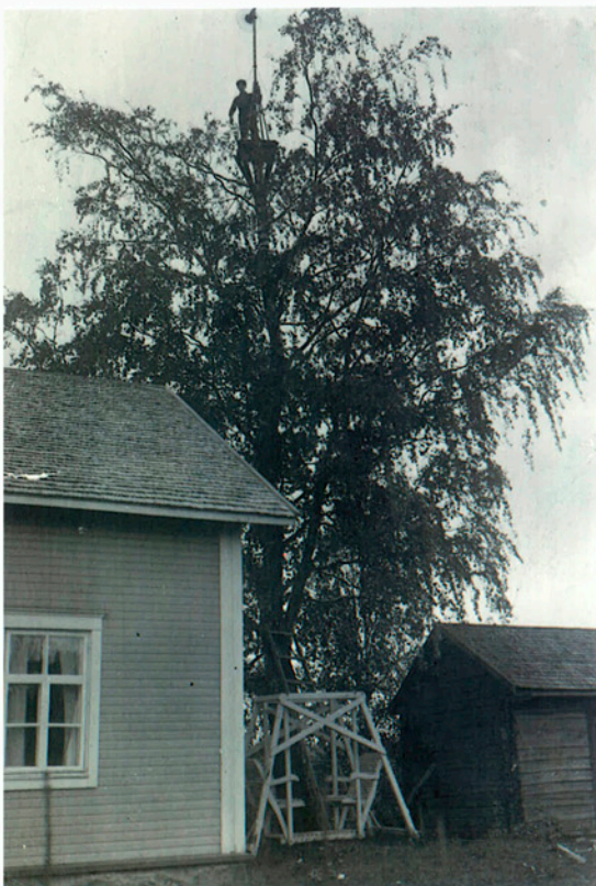
Tuulivoimaa Häsälään kotikoivun latvasta v. 1938. Laite oli heikkotekoisen ja sähköä ruvettiin vuoden päästä ostamaan Ilmeen Voima Oy:n linjasta valtatie varrelta. Puun latvassa laitteen toimittaneen seppä Hämäläisen poika.
